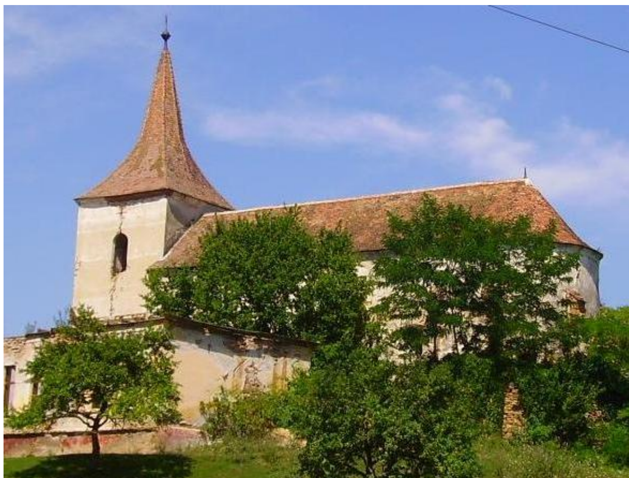
(Felmerer Kirche, August 2006, restauriertes Dach)
