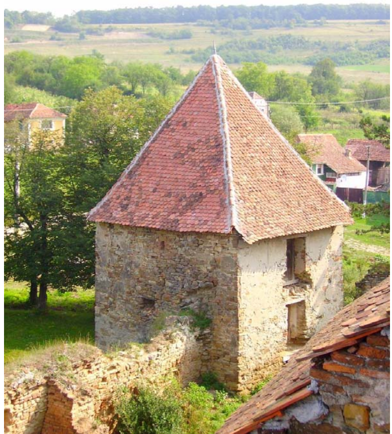
(Nord-West Turm nach Renovierung - 2007)
