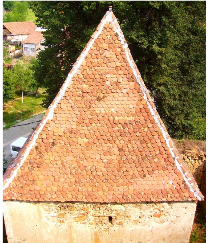
(Nord-Ost Turm nach Renovierung - 2007)
