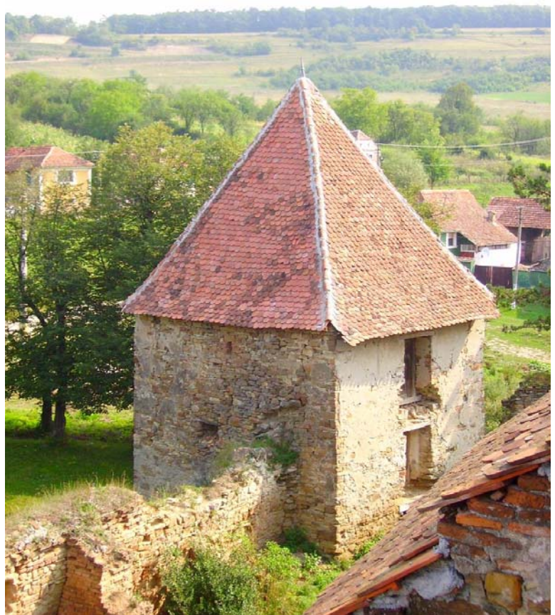
(Nord-West Turm nach Renovierung - 2007)
