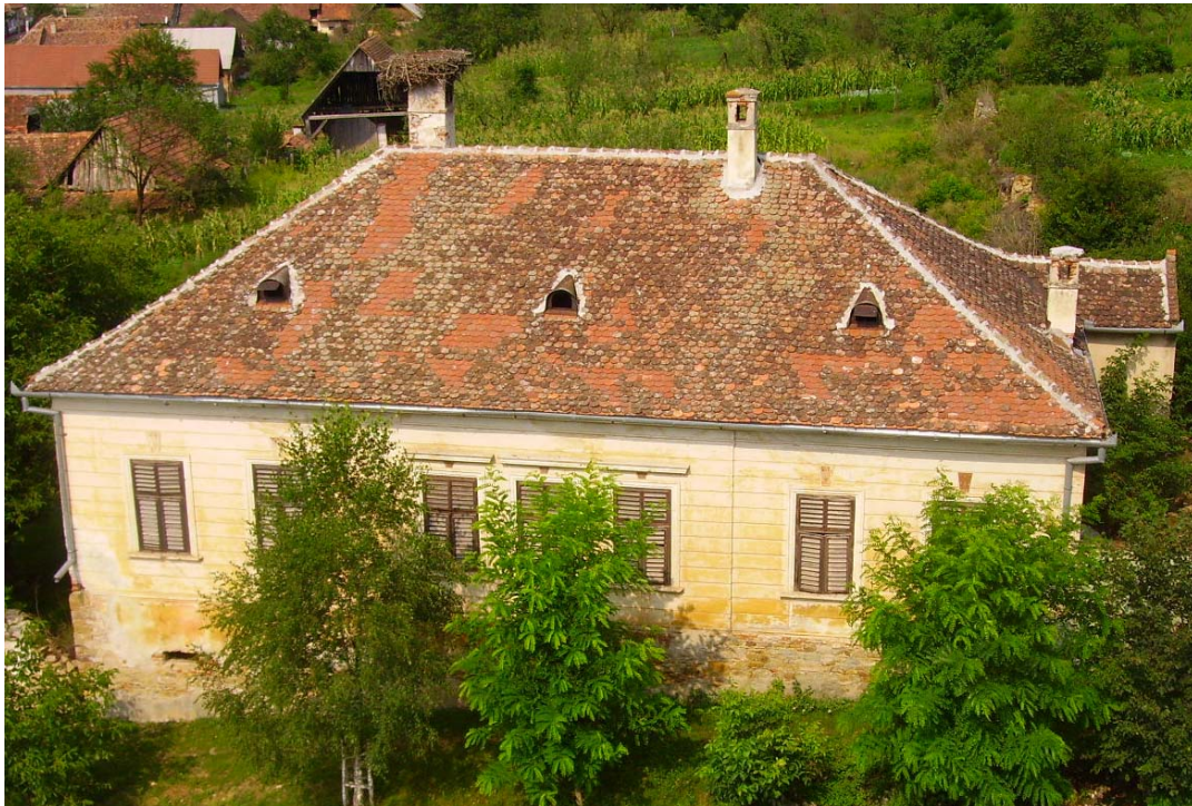
(Pfarrhaus mit renoviertem Dach - 2007)
